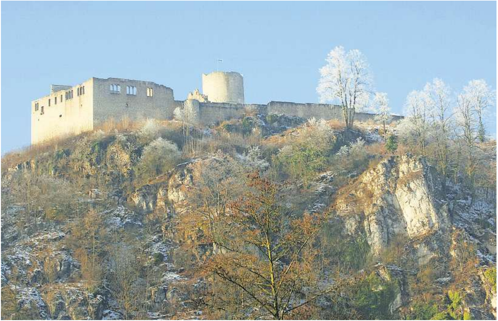
Der innere Wall der Burganlage wird durch den Bergverein entbuscht.
