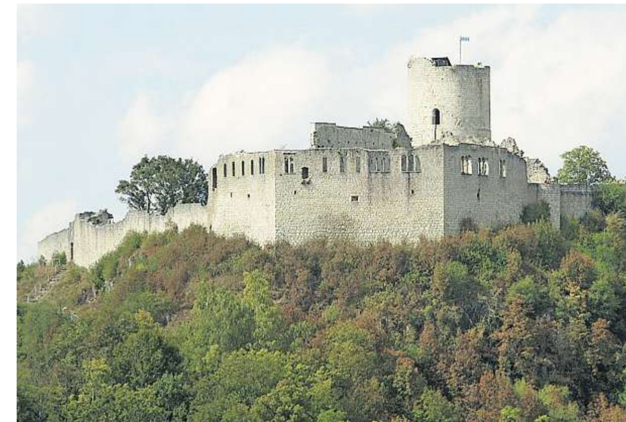
Der „Bergverein“ möchte die Marktgemeinde bei der Erhaltung und Sanierung des Ensembles „Schlossberg und Burgruine“ unterstützen.
